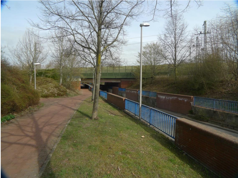
Zwei neue Gleise an der Südseite würden an der Brücke über die Heinrich-Drögemeier-Straße im Vordergrund verlaufen.
