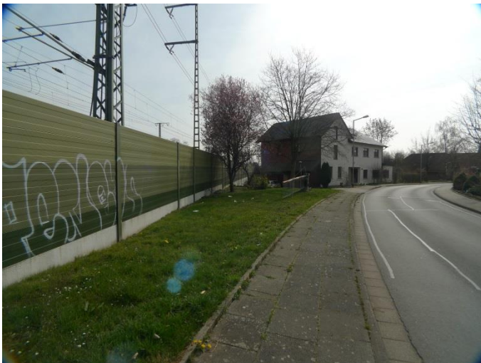
Bahnstraße: Dankersen: Dieses Haus müsste weiteren Gleisen weichen, wenn sie an der Südseite errichtet werden.
