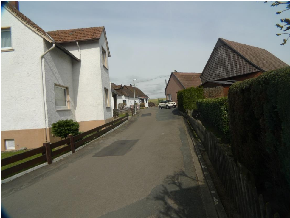
Auch die Häuser an Ende des Stichwegs Hünenbrink wären von zusätzlichen Gleisen an der Südseite betroffen.
