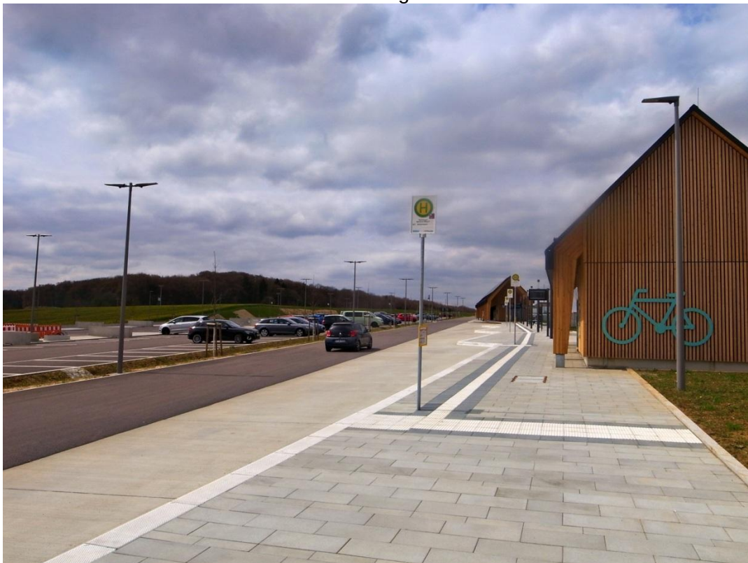
Merklingen: Blick auf die Stationsanlage mit Fahrradparkhaus (rechts) und kleiner Wartehalle (rechts hinten). Die Bahnlinie liegt weiter rechts unten im Einschnitt, der Zugang liegt neben der Wartehalle.
