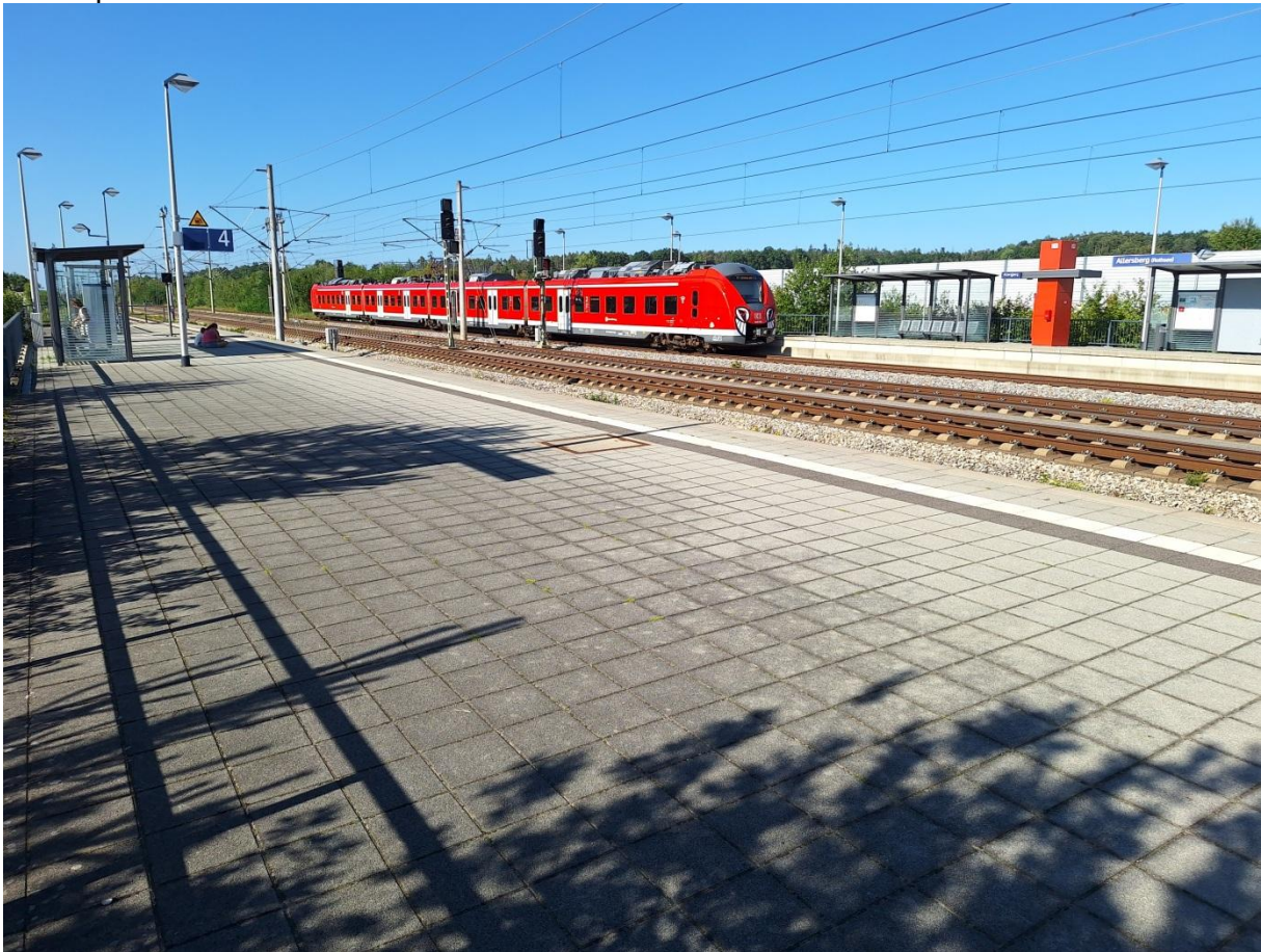
Allersberg: Blick auf die Bahnsteige. Die S-Bahn nach Nürnberg ist abfahrtsbereit und wird mit 160 km/h in nur 14 Minuten den Hauptbahnhof erreichen.
