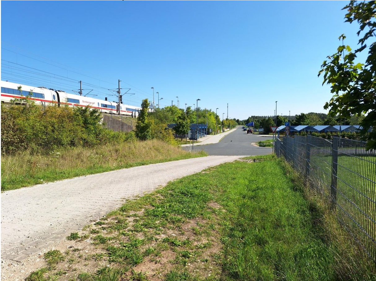
Allersberg: Blick aus Richtung Nordwesten auf die Stationsanlagen.
